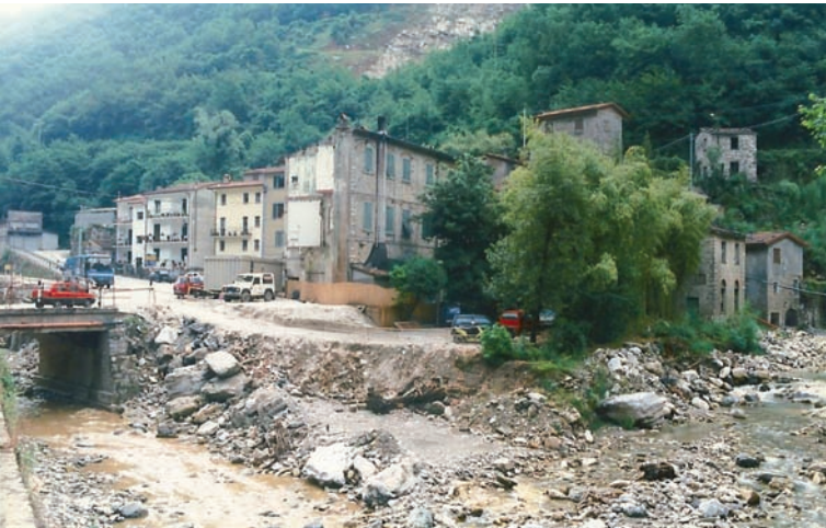
■ Alluvione in Versilia - Località Ponte Stazzemese
