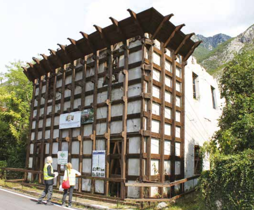
■ Opere provvisorie realizzate dai Vigili del Fuoco su un edificio danneggiato
