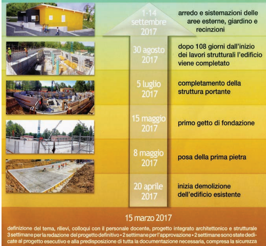
■ Nella grafica, le fasi salienti della ricostruzione della scuola
