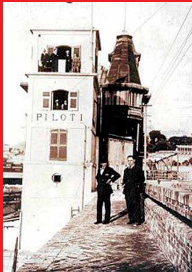
■ La nuova Torre piloti costruita nel 1913
