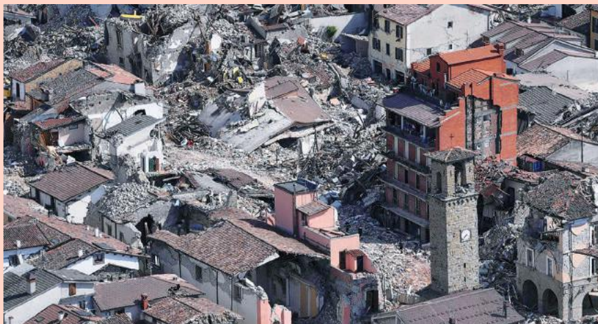
■ Il centro di Amatrice (Rieti) distrutto dal terremoto del 24 agosto
