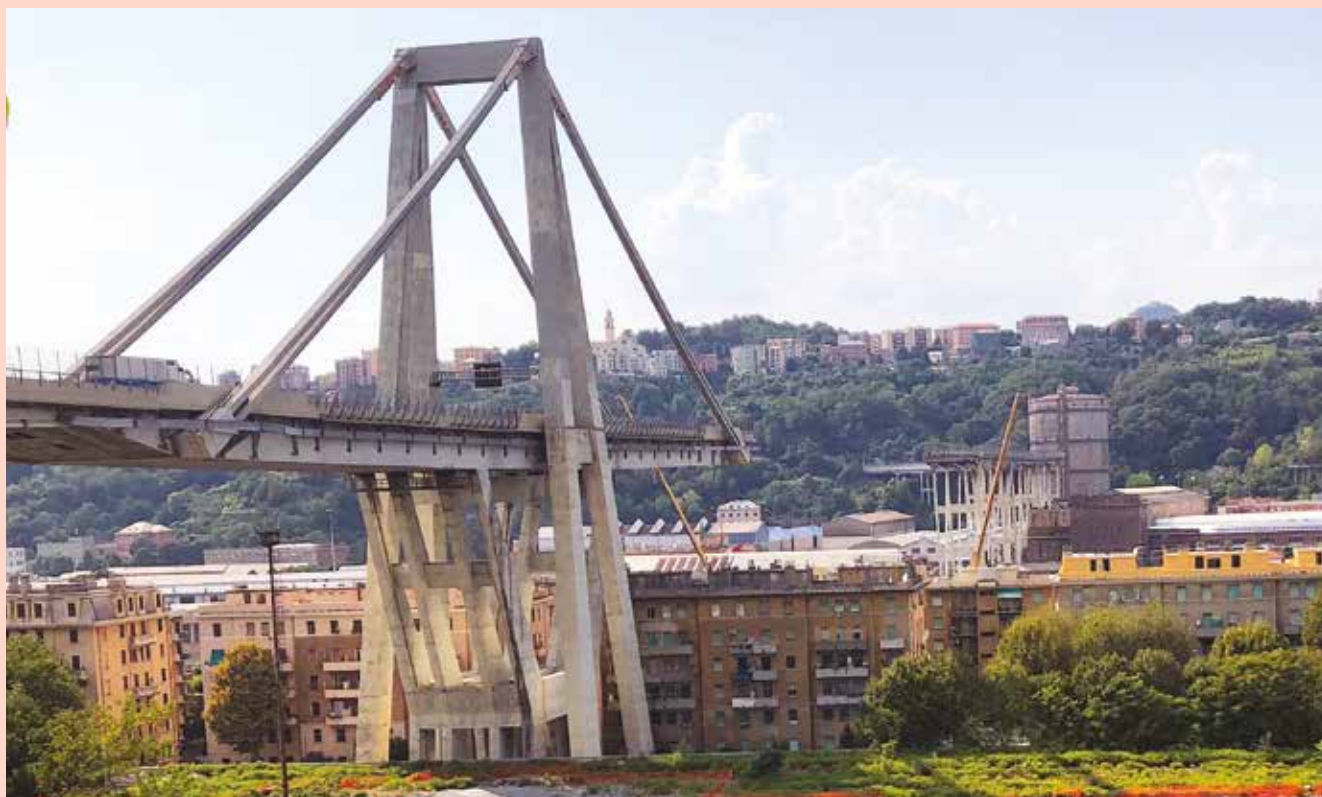
■ Il Ponte Morandi di Genova come appare dopo il crollo di una porzione il 14 agosto scorso
